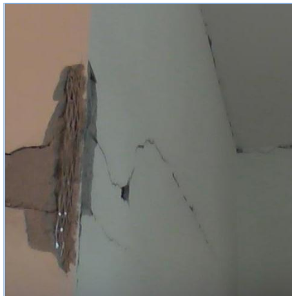
Rottura per scorrimento orizzontale
