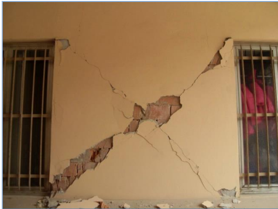
Rottura diagonale per trazione
